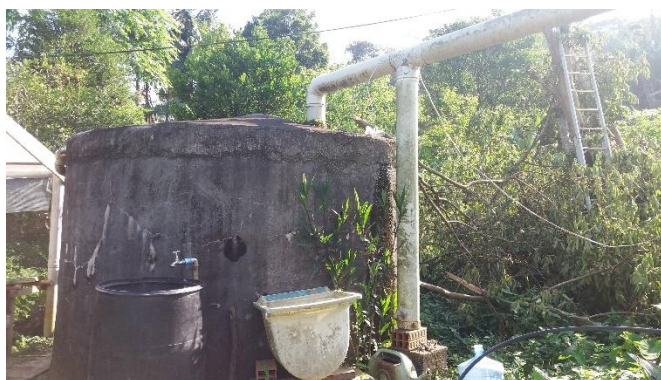
Figura 23 – Cisterna para coleta de água da chuva usada para rega de mudas
