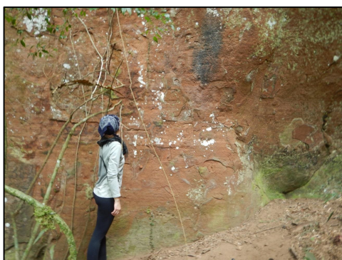
Figura 13 - Vista frontal do paredão com os painéis.
