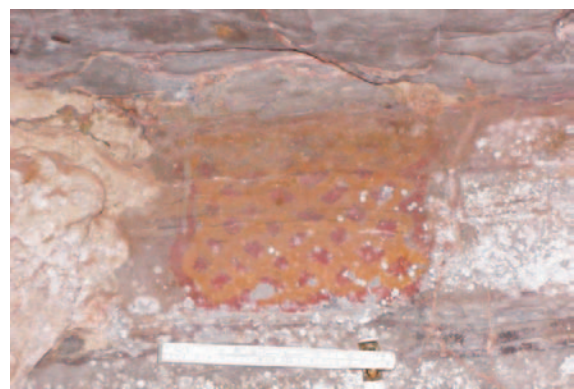
Túnel do Morro Furado
