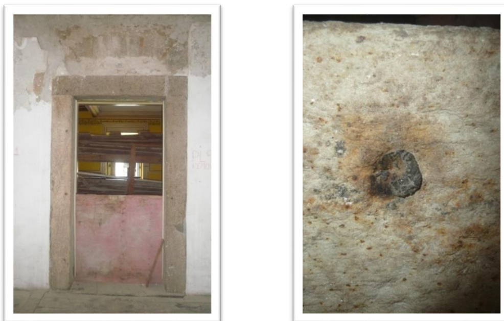
FIGURA 30: Marcas de inserções de ferro nos portais do quarto de Dona Maria I, no piso 2 do Bloco I. Sugerem serem pinos de ferro usados como suportes de uma grade.
