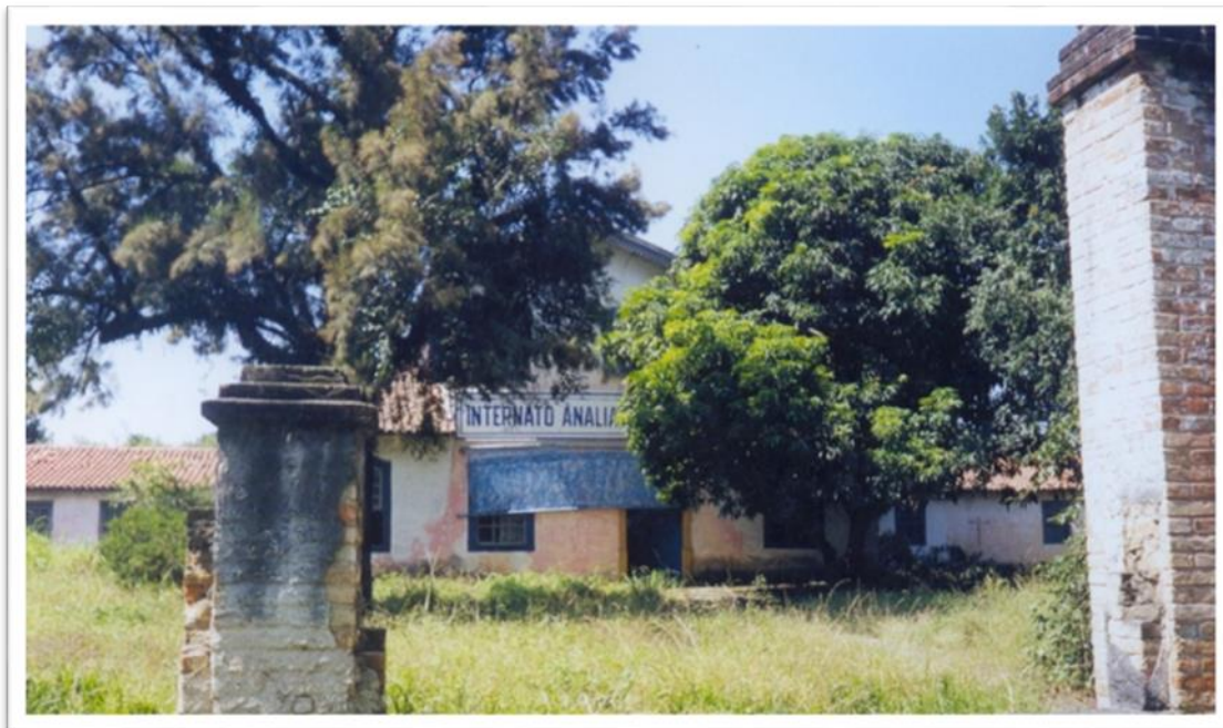
FIGURA 100: Entrada principal do Sítio do Capão antes das obras de restauro.
