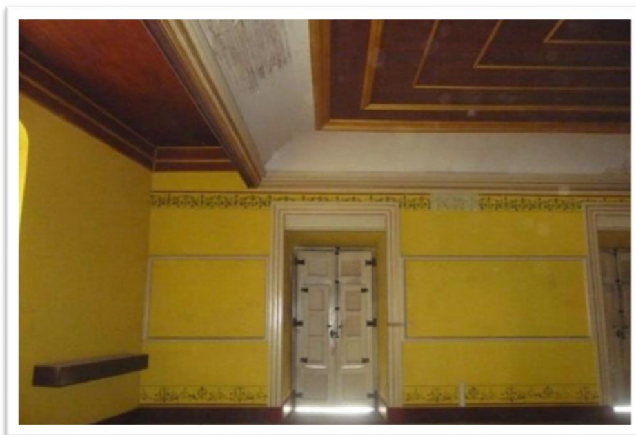
FIGURA 29: Quarto onde viveu Dona Maria I, o cômodo melhor preservado do Antigo Convento do Carmo.
