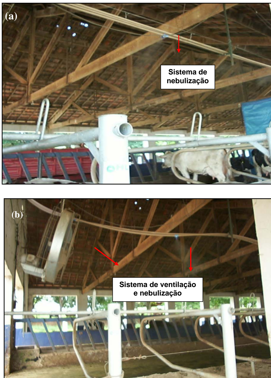
Figura 6- Free-stall climatizado com nebulização (a) e ventilação (b), Nova Odessa (SP)
