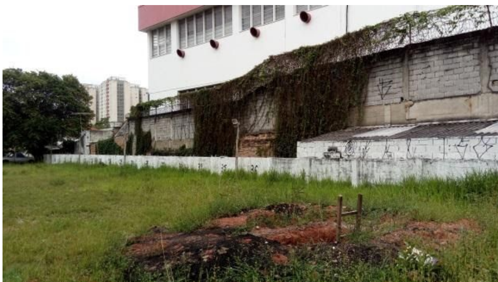
Figura 21 - Vista da TR02/TRAD2 aos fundos da empresa de motores.
