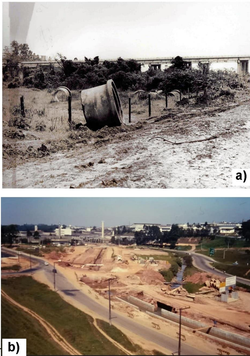
Figura 24: Fotografias relativas às intervenções nos córregos: a) Década de 1970, atual avenida Dr. Ulysses Guimarães, na altura da Rodovia dos Imigrantes, com dutos de cimento relacionados ao tamponamento e canalização do Córrego Floriano; b) Obras relacionadas à retificação do córrego da capela, notar que ambas as fotos indicam exposição de material aos agentes climáticos no período de urbanização ativa.
