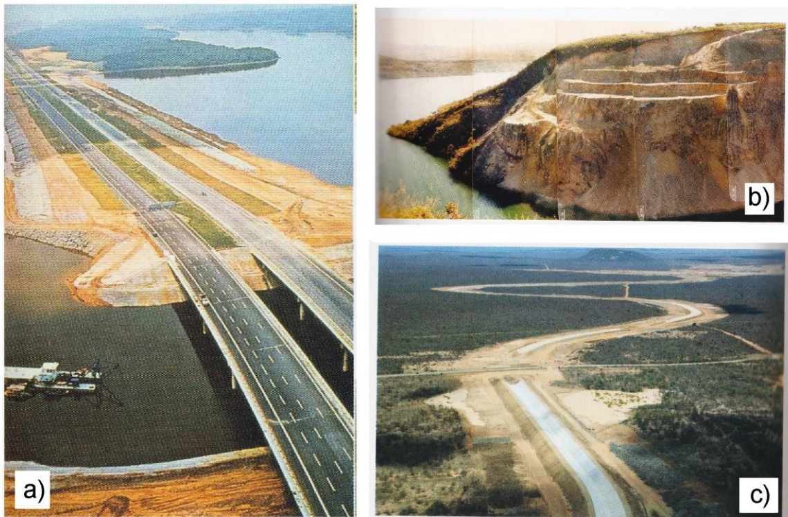
Figura 6: Exemplos de modificações antropogênicas. a) Vista aérea do aterro (forma de acumulação) para a Rodovia Anchieta; b) Montagem fotográfica que mostra a escavação e taludamento do Morro dos Cabritos, forma de remoção relativa às obras da Usina Hidrelétrica de Furnas, Rio Grande, Minas Gerais; c) Vista aérea do canal artificial CN-01, eixo norte da Transposição do Rio São Francisco, como exemplo de modificações diretas hidrológicas. Fonte: Bartorelli et al. (2017).
