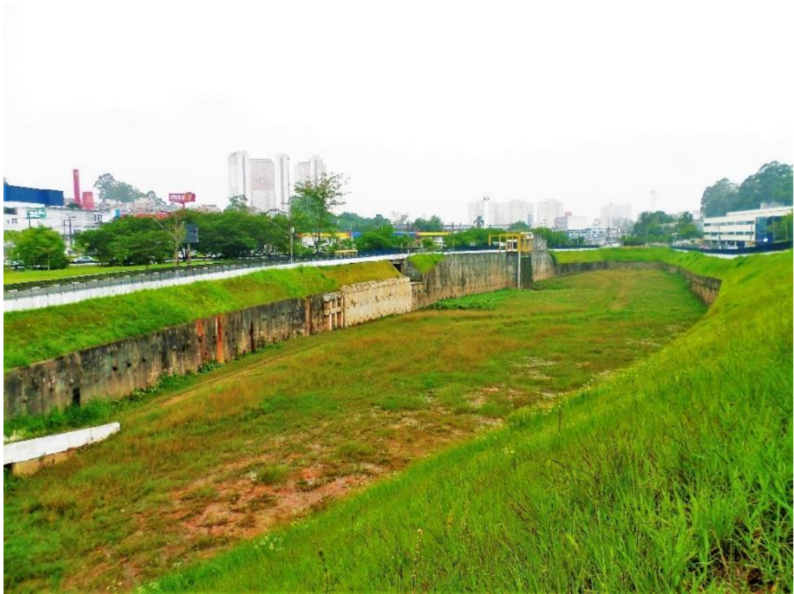
Figura 2: Reservatório de contenção de cheias Piscinão Ecovias/Imigrantes. Localizado na área de estudo na planície do Córrego da Capela, é um exemplo de modificações antropogênicas no modelado através de escavação. Fotografia: Eduardo Luiz Morari (2021).
