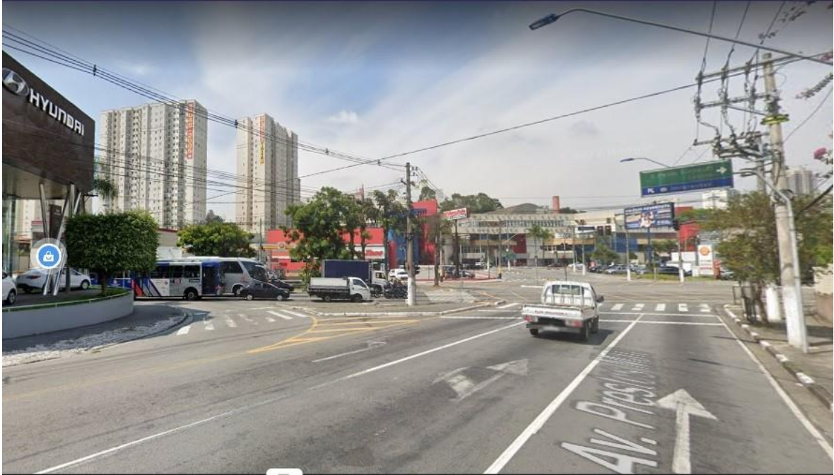
Figura 17: Aspecto atual da urbanização de Diadema na bacia hidrográfica do Córrego da Capela. Fonte: Adaptado do Google Street View (2023) por Eduardo Luiz Morari (2023).
