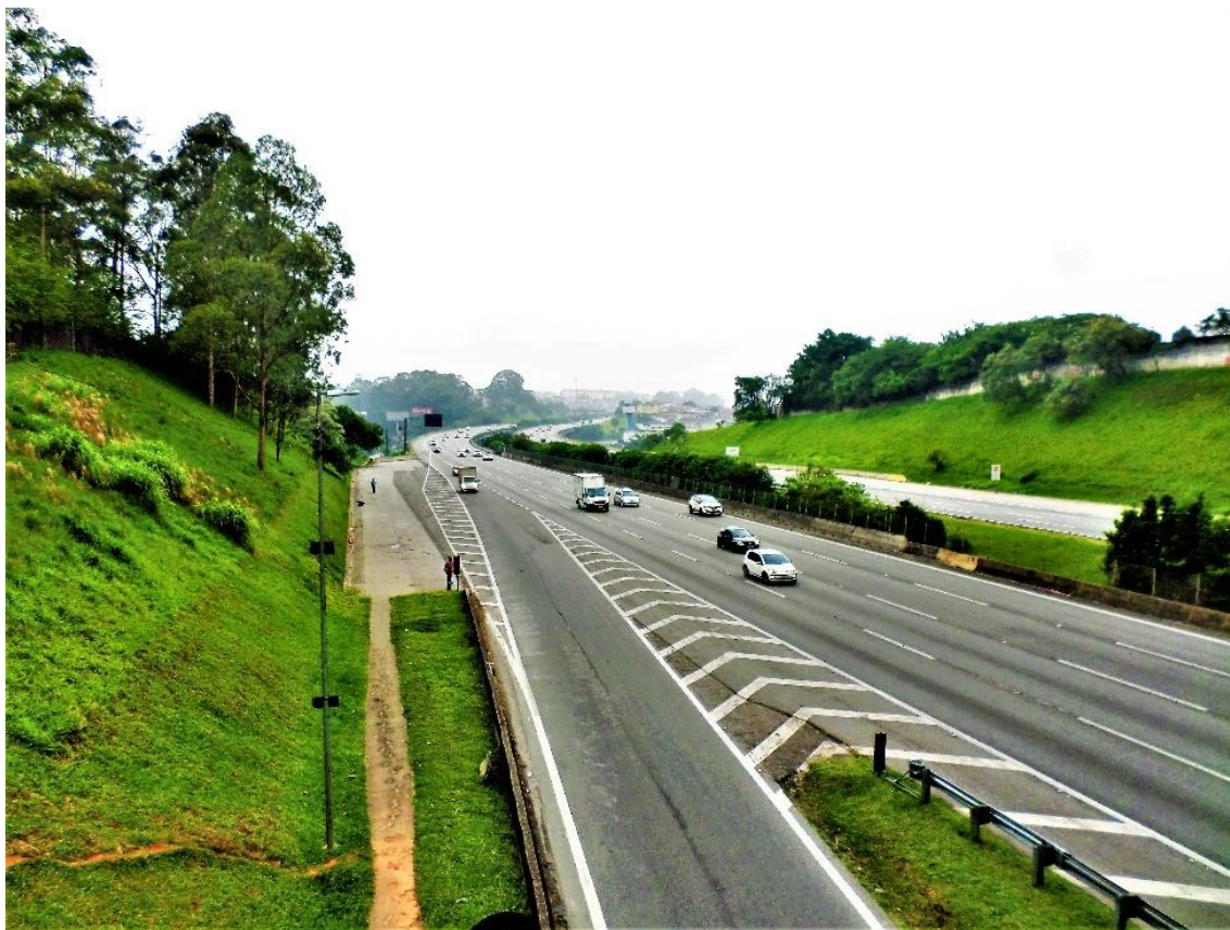
Figura 3: Trecho da Rodovia dos Imigrantes na área de estudo onde o interflúvio foi rebaixado por escavações. Fotografia: Eduardo Luiz Morari (2021).
