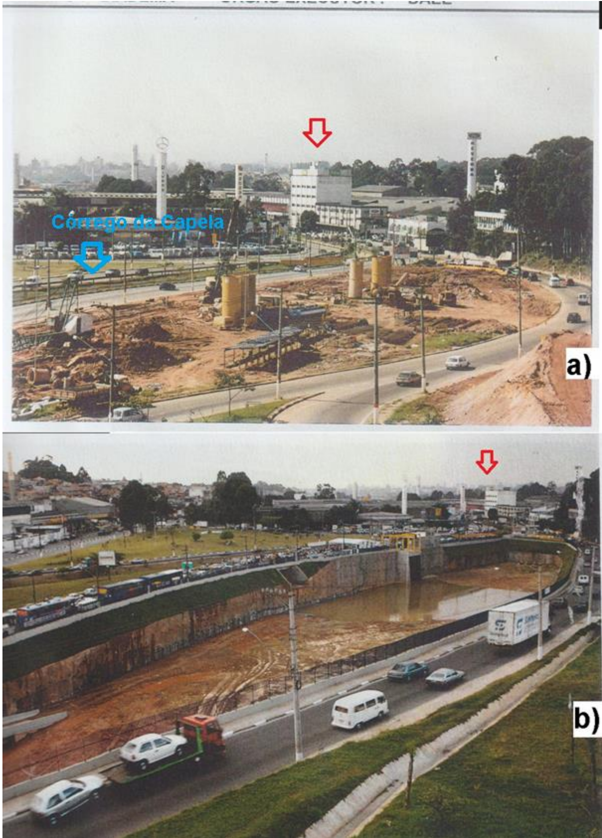
Figura 26: Intervenção na planície do córrego da capela para construção do piscinão. a) Início das escavações; b) Inauguração do piscinão em 2002. Fonte: Modificado de DAEE, 2002.
