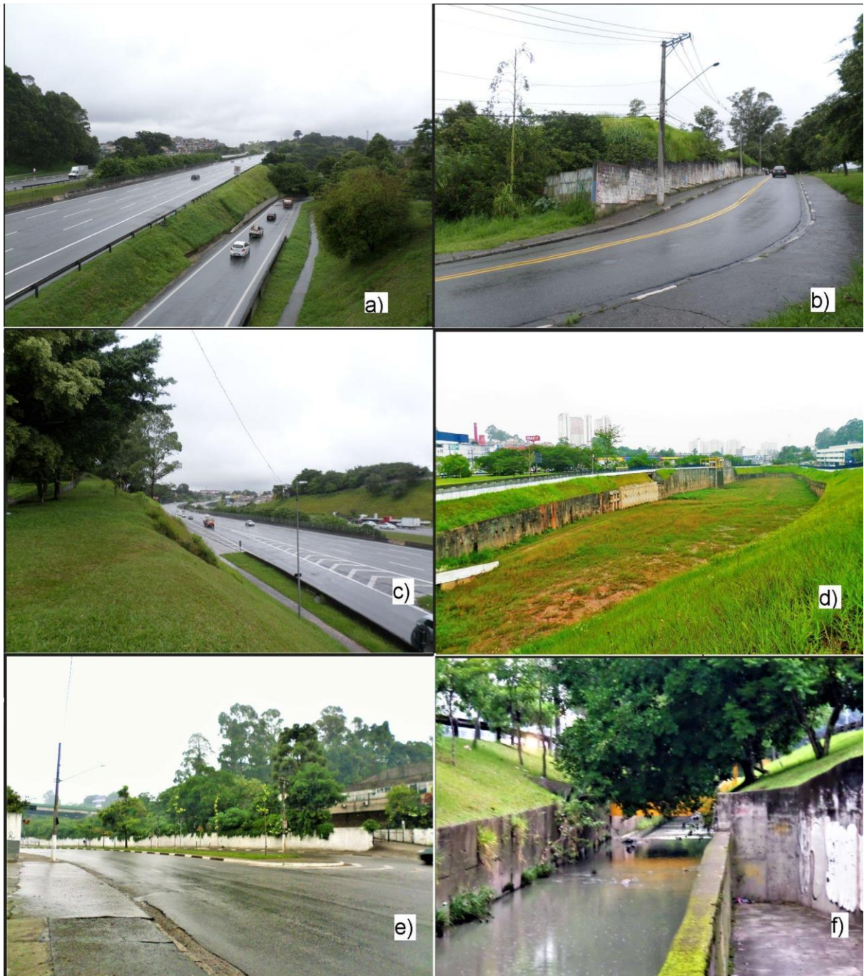
Figura 27: Mosaico de fotografias do período de urbanização consolidada: a) Patamares de aterro sobre vertente e planície fluvial realizados para dar sustentação ao viaduto da Rodovia Imigrantes; b) Patamar de aterro; c) Colo antropogênico relacionado às escavações da Rodovia Imigrantes; d) Piscinão Ecovias-Imigrantes, com área rebaixada na planície fluvial por escavação (forma negativa) na planície fluvial ; e) Planície fluvial impermeabilizada do Córrego Floriano canalizado; f) Trecho do córrego da capela retificado com vertedouro de fluxo para o Piscinão. Fotografias: Eduardo Luiz Morari.
