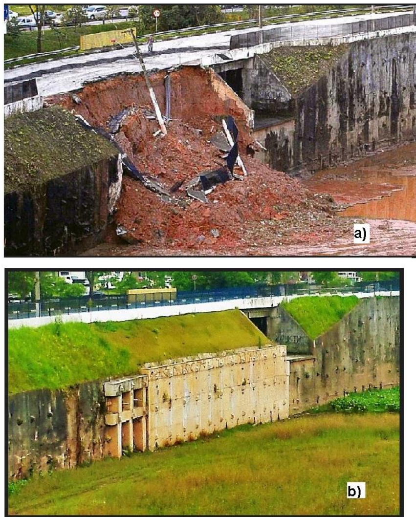
Figura 32: a) Rompimento do talude em 2017 (DAEE 2017); b) Obra de engenharia para recuperação do talude concluída. Fotografia: Eduardo Luiz Morari, 2022.
