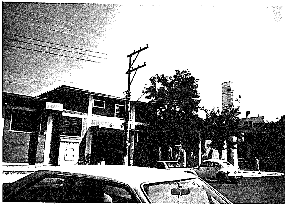
Fotografia nr. 2: Vista externa do novo mercado municipal central de Porto Velho, após ter passado por recentes reformas.
