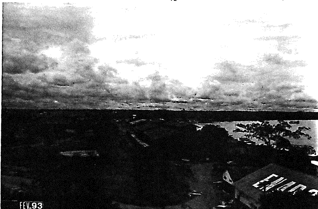
Fotografia nr. 20: lugar das instalações da EFMM: pátio de manobra, armazéns; lugar onde nasceu Porto Velho.
