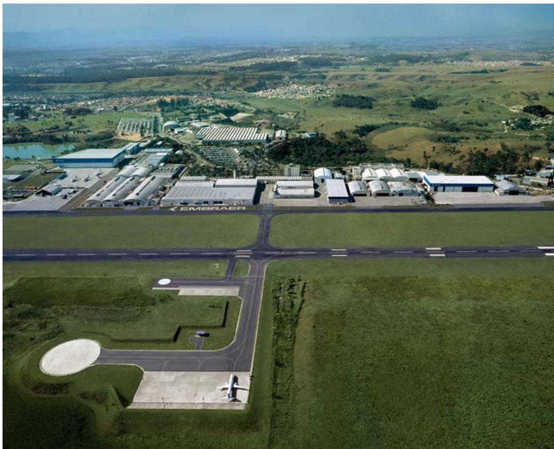
Figura 25 – Vista aérea da Empresa Brasileira de Aeronáutica S.A. - 2006.
