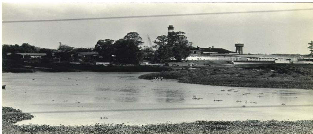
Figura 6 – Vista parcial das instalações da Companhia Rhodosá de Rayon.
