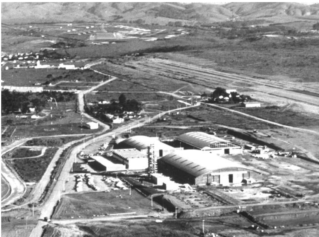
Figura 24 – Vista aérea da Empresa Brasileira de Aeronáutica S.A. - 1969.
