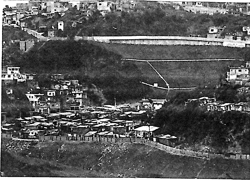
FOTO 5 - Trabalho de contenção das encostas. A prefeitura tem procurado realizar serviços para conter o deslizamento das encostas.
