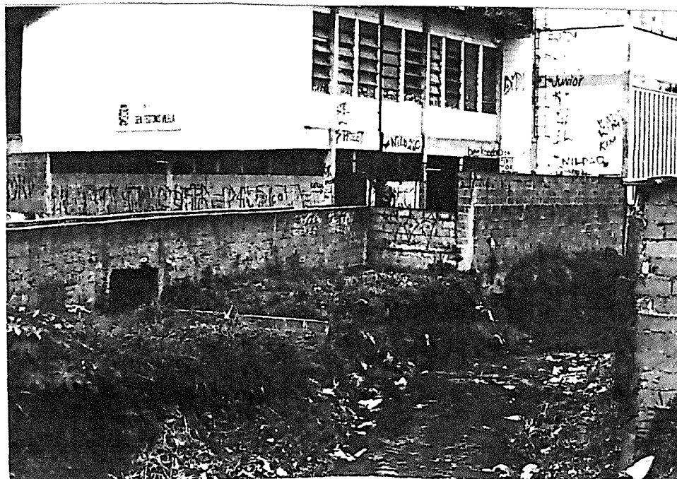
FOTO 8 - E.M.P.G. Teotônio Vilela. Construída em local alagadiço, quando em temporada de chuvas, são grandes as dificuldades dos alunos para chegar à escola.
