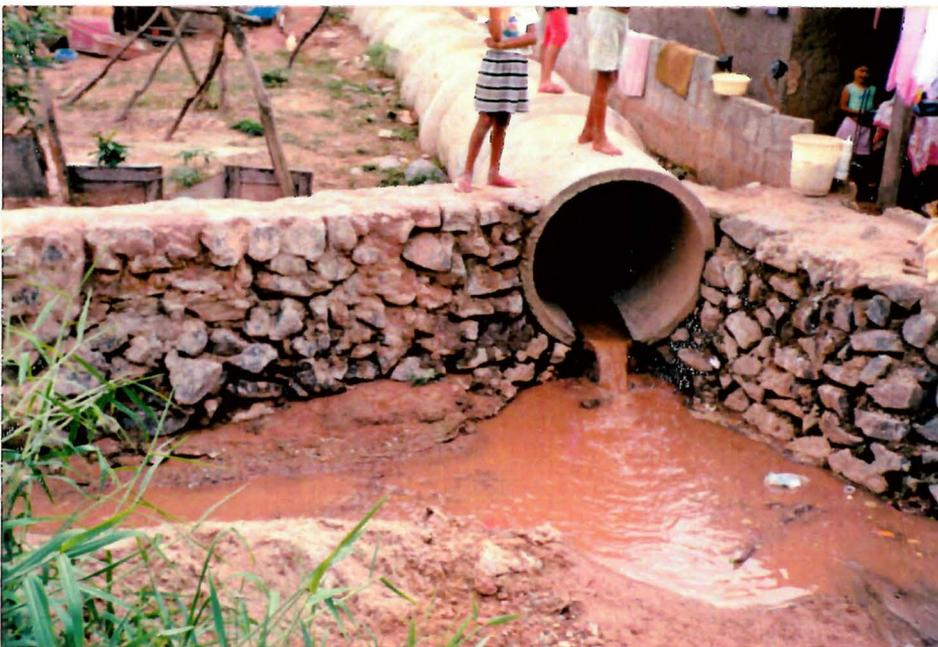
Esgoto domiciliar ligado em tubulação de águas pluviais.
