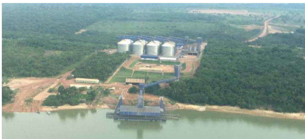
Figura 7 - Foto aérea da ETC da Hidrovias do Brasil, Miritituba
