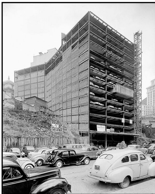
Figura 7 – Edifício garagem América, em fim de obra e já em uso (1954
