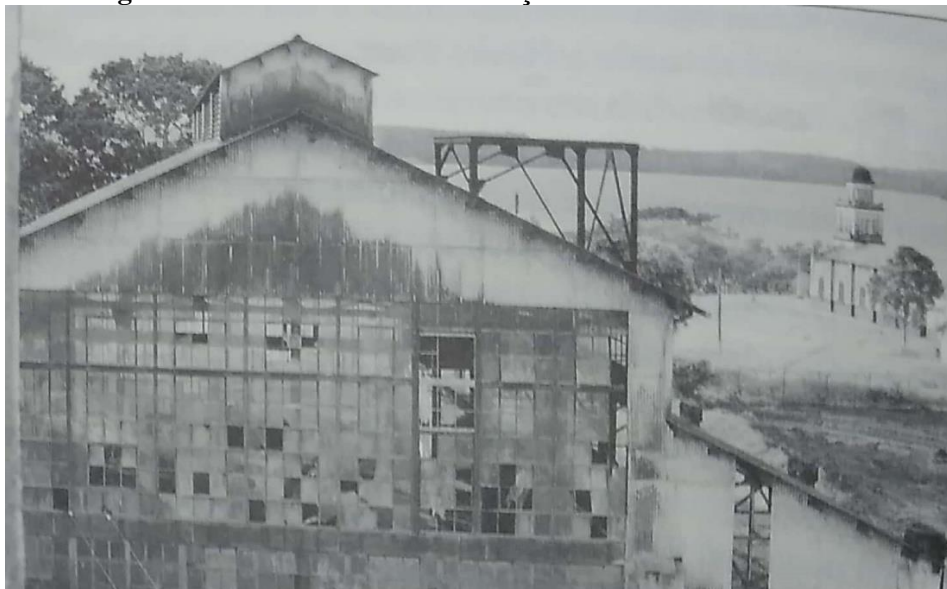
Figura 02 - Ruínas da usina de força da Fordlândia/Aveiro/PA
