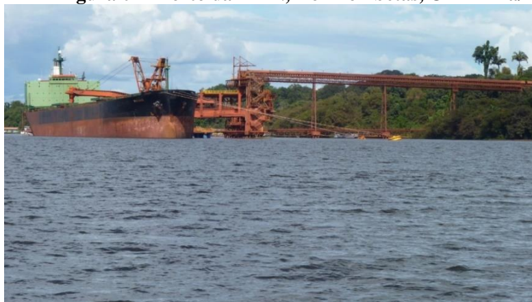
Figura 07 - Porto da MRN, rio Trombetas, Oriximiná/PA
