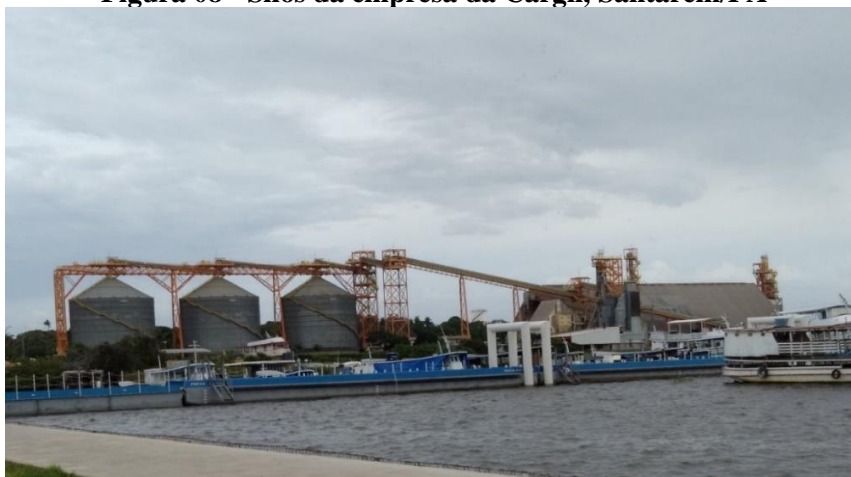
Figura 08 - Silos da empresa da Cargil, Santarém/PA
