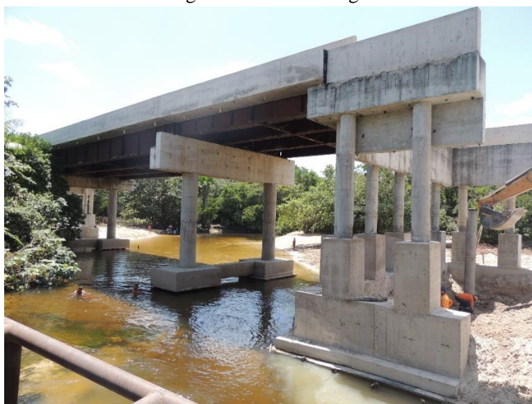
Figura 26: Ponte sobre Rio Alegre no Povoado Alegre na rodovia estadual MA-320.
