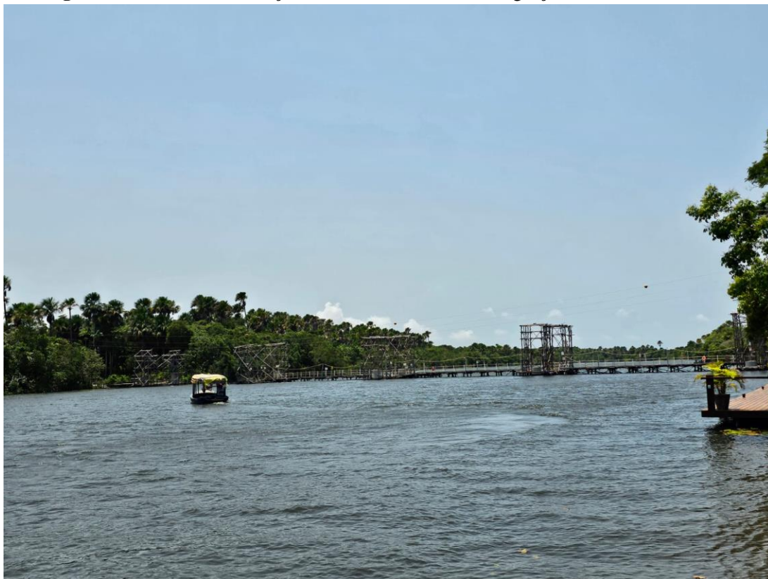
Figura 28: Foto da Construção da Ponte sobre o Rio Preguiças – Barreirinhas-MA.
