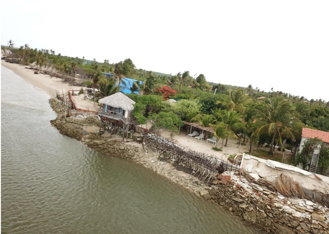
Figura 44: Foto de drone da erosão costeira em Atins.
