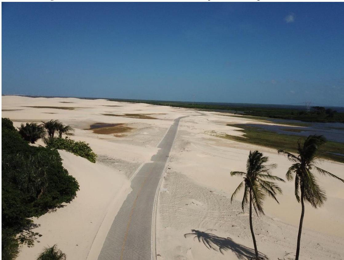
Figura 24: Foto de drone da MA 315, trecho próximo a Lagoa da Taboa.
