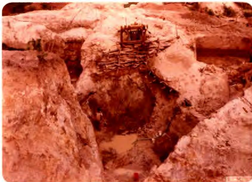
Foto 1 - Água minada num "serviço" do garimpo Ingazeira, vendo-se a mangueira e a bomba para puxá-la. Observa-se, ainda, o emalhe preparado para sustentar o barranco e evitar seu desmoronamento. Abril de 1979.
