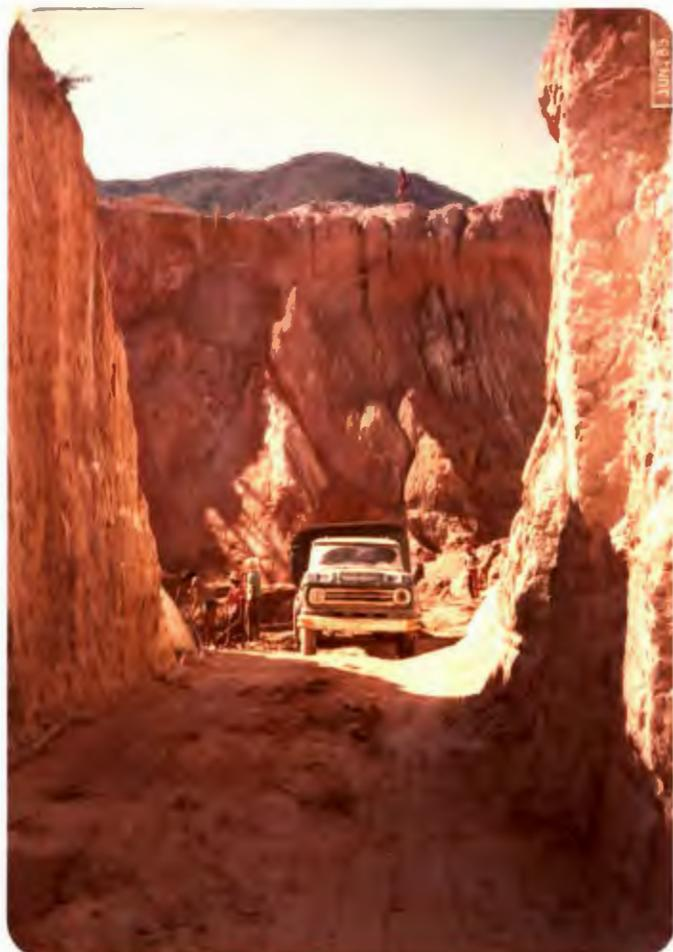
Foto 5 - "Valeta" que permite a entrada de caminhões-basculantes no "monchão" do garimpo Ingazeira, a fim de retirar o estéril, de simpedindo a área mineralizada e facilitando os trabalhos de extração. Junho de 1981.
