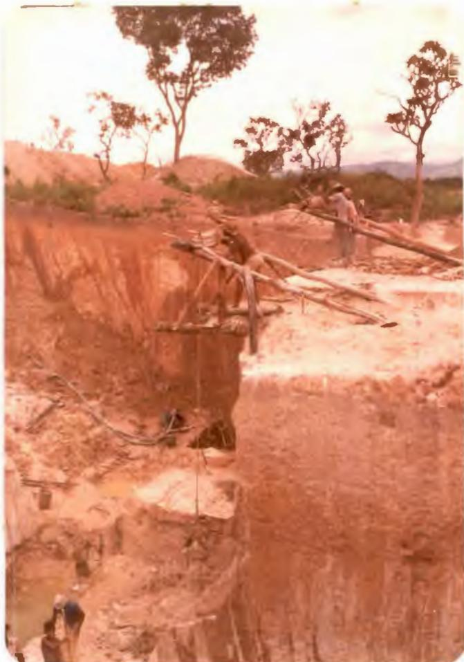
Foto 7 - Nos "serviços" entre cerca de 3 a 10 metros de profundidade, usava-se o sarilho puxando um pedaço de couro chamado "bandeira" para retirar o estéril e o minério extraído das catas, no garimpo Ingazeira. Abril de 1979.
