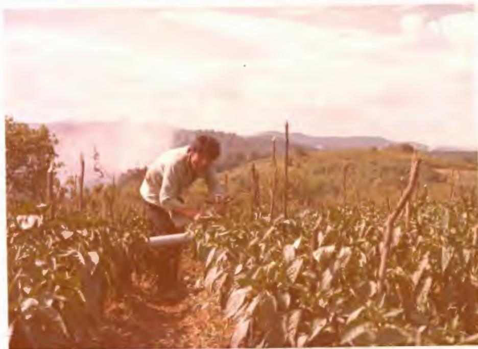
FOTOS 22-23. Irrigação na cultura de pimentões. Montagem das tubulações de PVC utilizadas na irrigação por aspersão, numa área em fase de produção. (Fotos da Autora)
