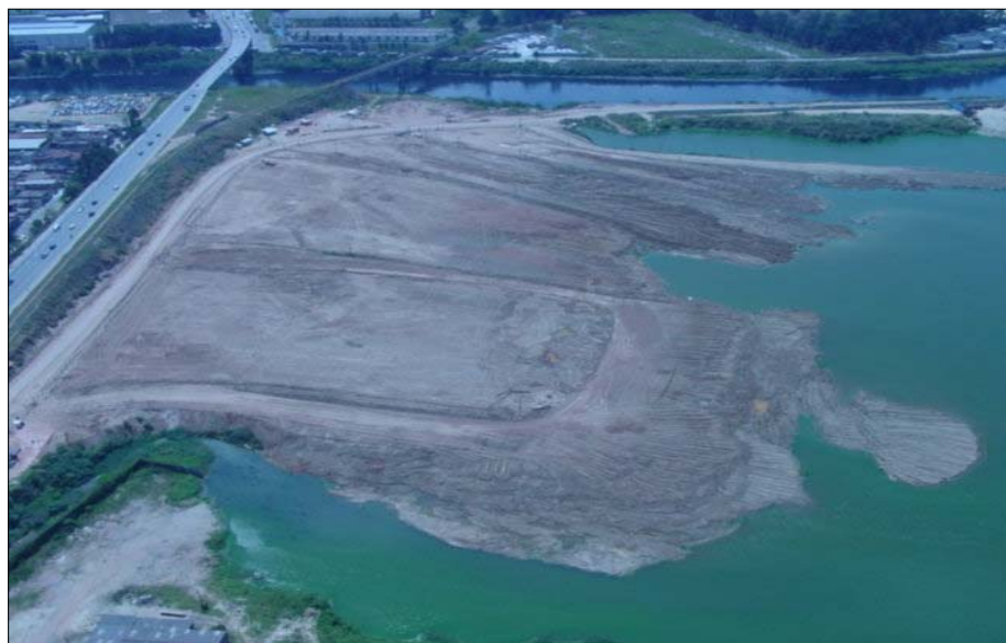
FIGURA II.26 – Aterro da margem oeste da Lagoa de Carapicuíba, em 2003
