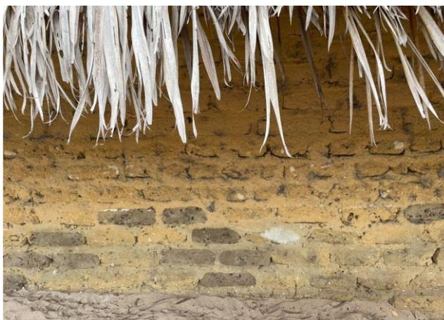
Figura 23 - Foto de um detalhe de tijolos de barro.
