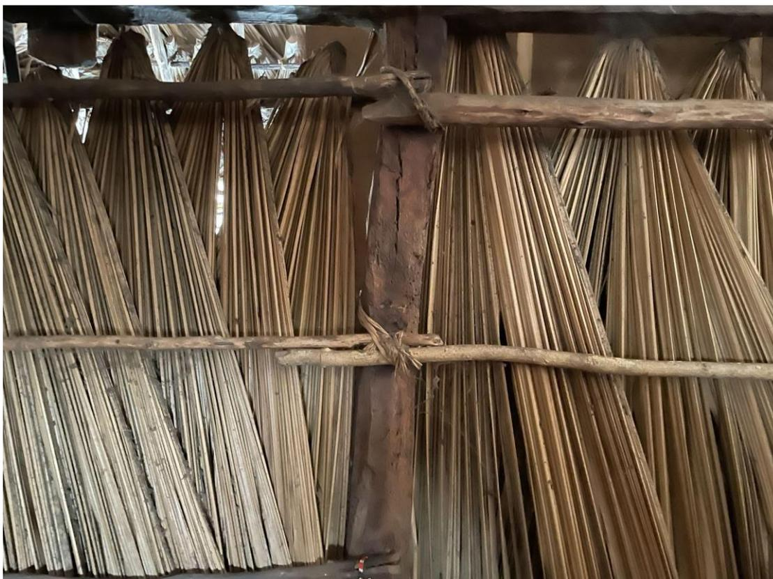
Figura 17 - Foto do detalhe construtivo de uma vedação em palha.
