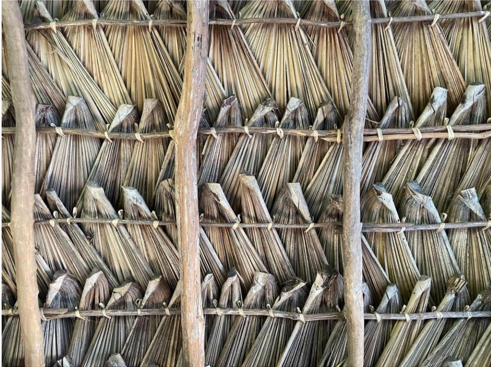
Figura 13 - Foto do detalhe construtivo da cobertura de palha.
