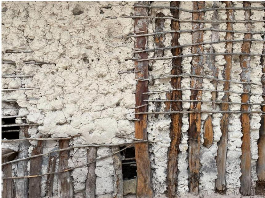
Figura 20 - Detalhe construtivo da taipa de sebe.
