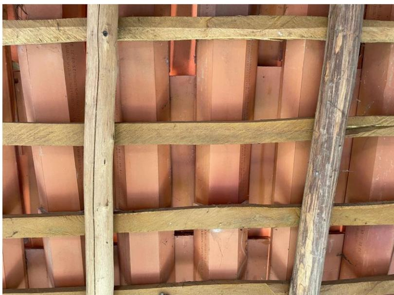
Figura 15 - Foto do detalhe construtivo da cobertura de telha cerâmica.
