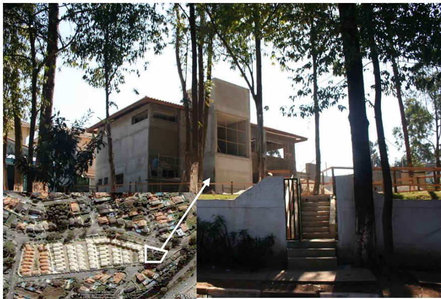
Foto 18 – Prédio da futura sede da APRPP. Maria Maio, agosto/ 2009.
