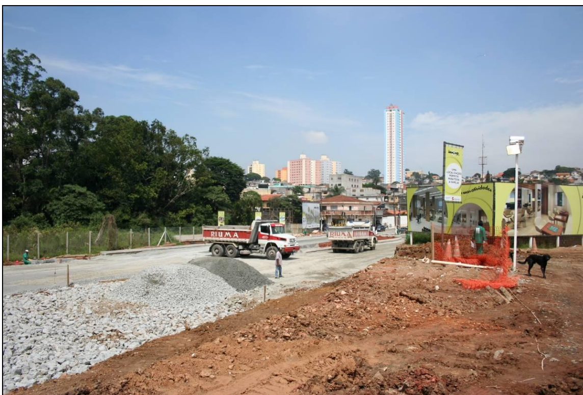
Foto 17 – Construção da Av. Estados Unidos no Município de Osasco.
