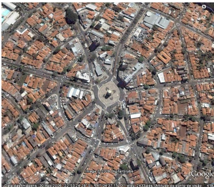
Foto 4B – Vista aérea atual da região do Mirante do Castelo. Muitas transformações na paisagem desde o início das intervenções do plano de Prestes Maia. (Fonte: Google Earth – Foto de 30/08/2006).
