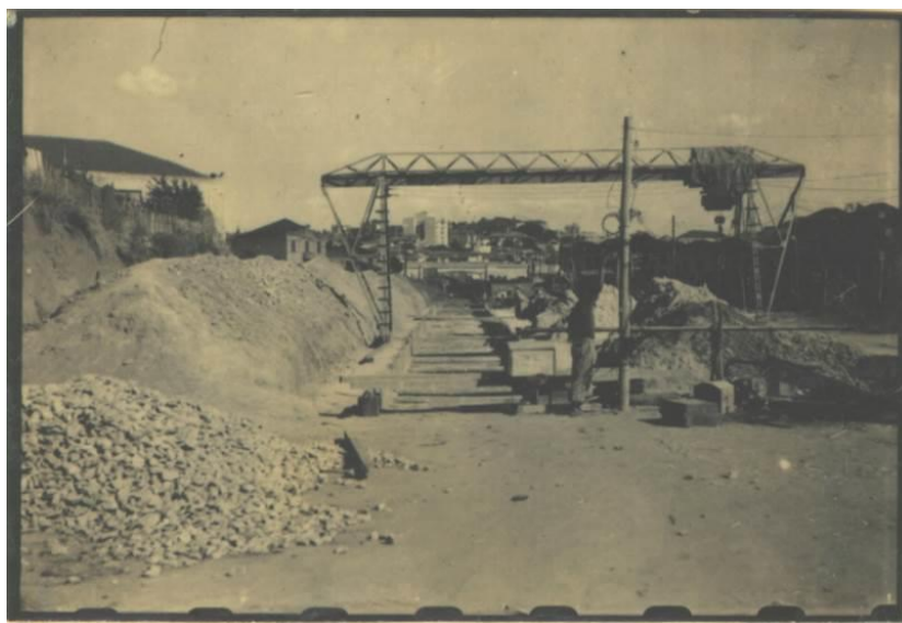
Figura 7. Construção do Viaduto Pacaembu
