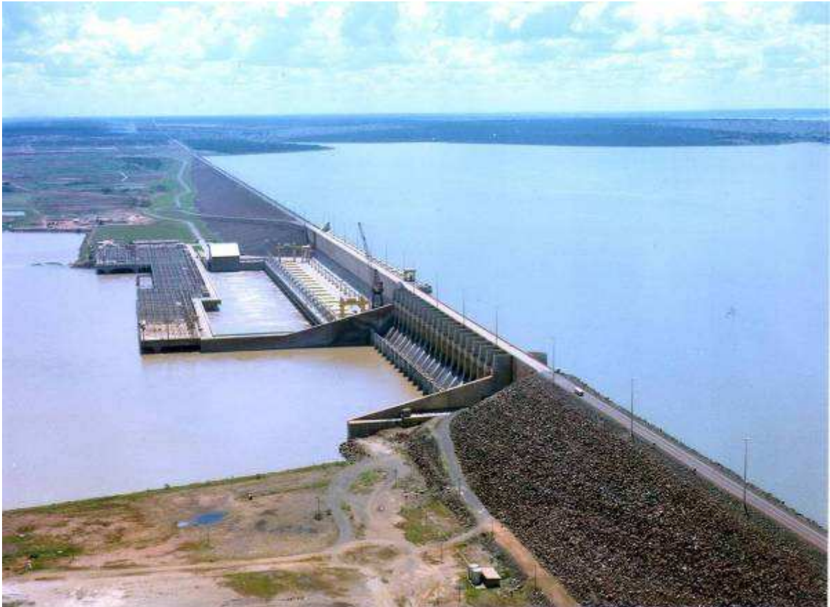
Fig. 4.7: Vista geral da Usina de Ilha Solteira onde se observa, à frente da casa de máquinas, a subestação montada sobre plataforma de concreto construída sobre o leito do rio, s.d.
