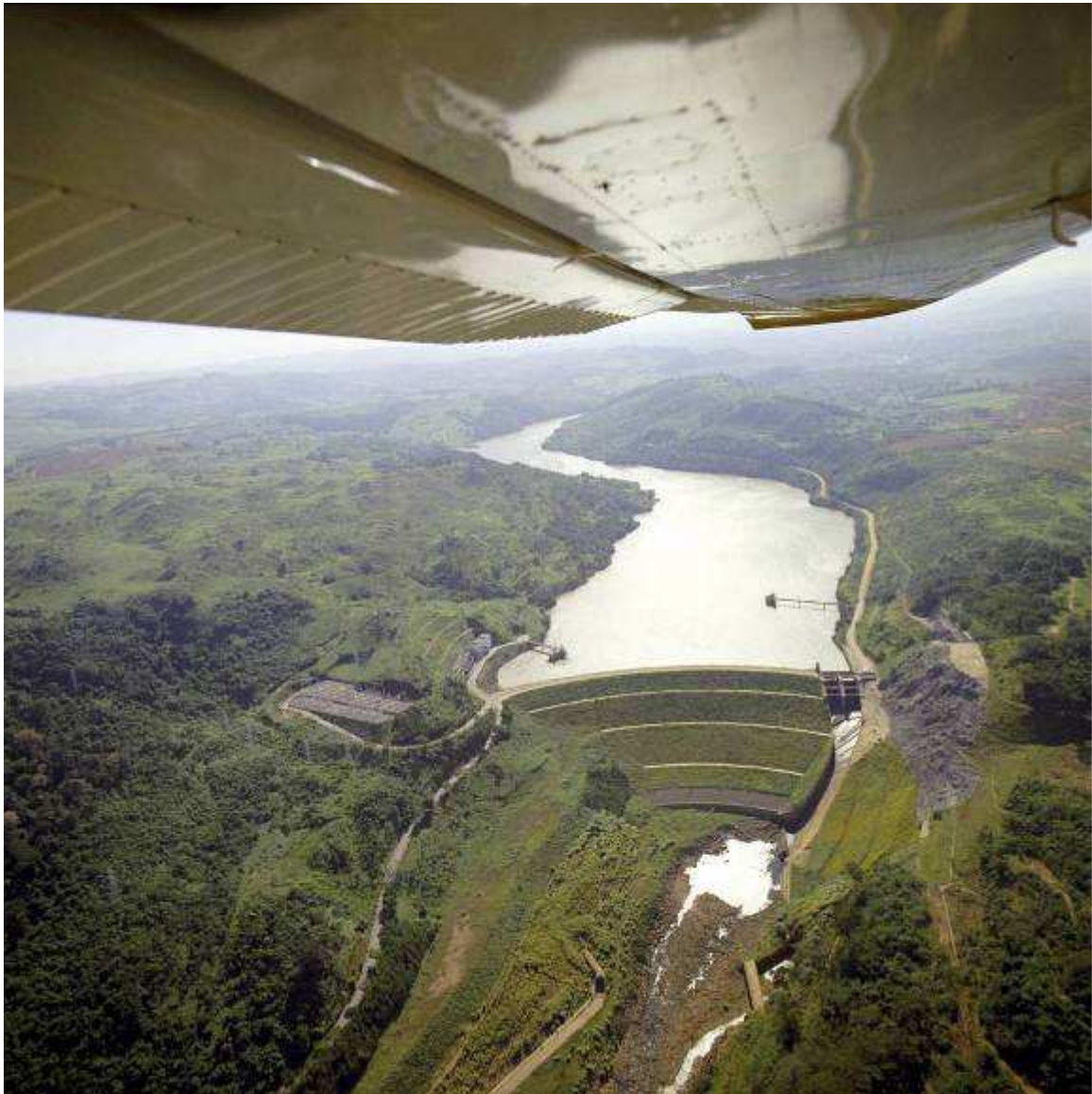
Fig. 2.7: Usina Hidrelétrica Euclides da Cunha 109 MW, Rio Pardo (São José do Rio Pardo-SP), início de operação: 1960. Primeira usina da CHERP, cuja construção civil ficou a cargo da Construções e Comércio Camargo Corrêa
