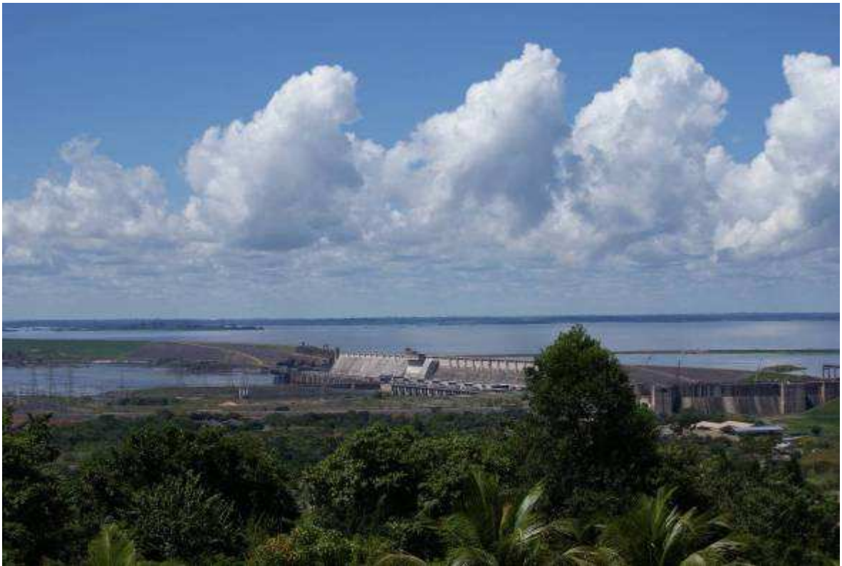
Fig. 1.3: Usina Hidrelétrica de Tucuruí, 8.370 MW, Rio Tocantins (PA), início de operação em 1984, a maior usina hidrelétrica em operação no país (Itaipu é binacional)
