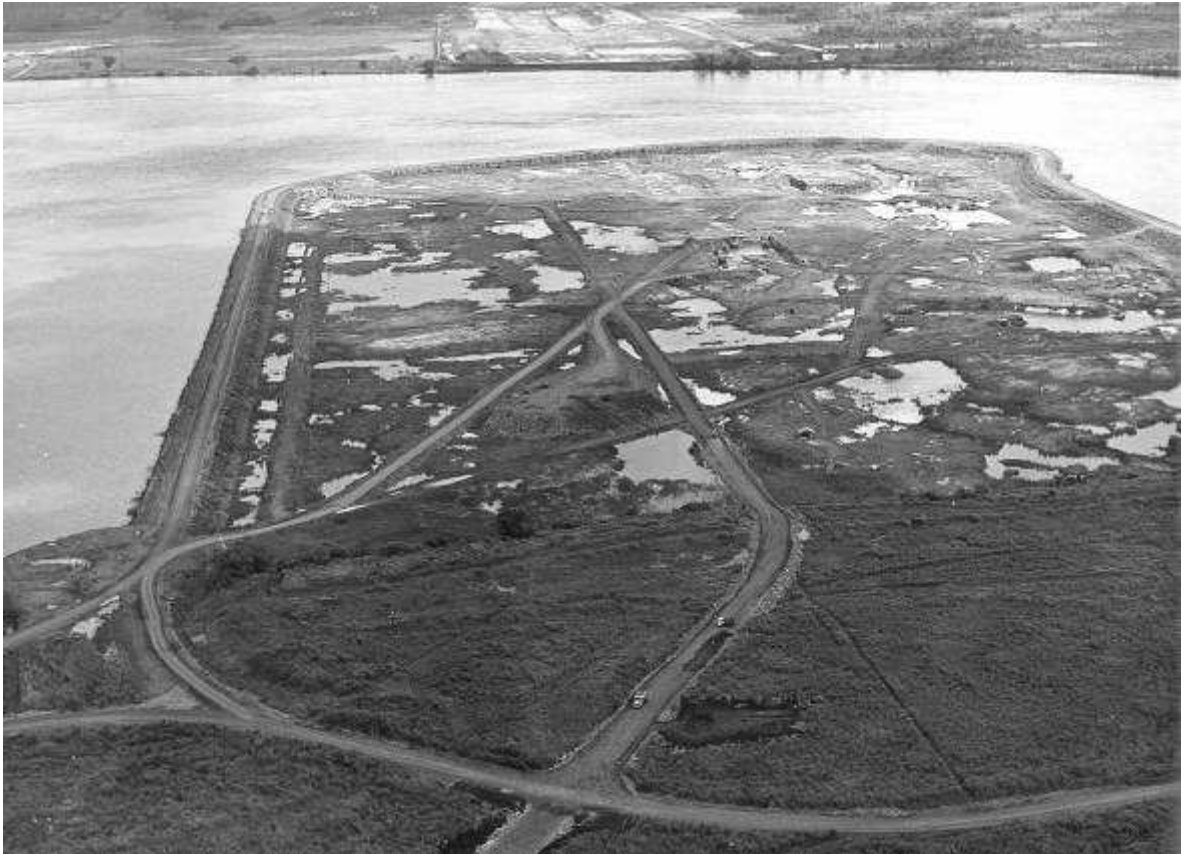
Fig. 4.4: Início da construção da ensecadeira no rio Paraná, Usina de Ilha Solteira, 1967 Crédito: acervo Centro de Documentação e Memória Camargo Corrêa – CDMCC
