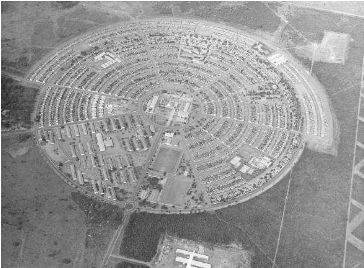
Fig. 1.8: Vila residencial do canteiro de obras da Usina de Jupirá (depois Eng. Souza Dias), necessidade de construir uma cidade provisória e completa para acomodar os milhares de trabalhadores envolvidos com a obra
