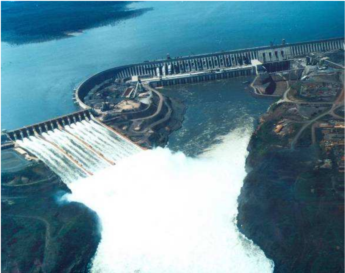
Fig. 1: Usina Hidrelétrica de Itaipu, 14.000 MW, Rio Paraná (Brasil/Paraguai), início de operação: 1983, equipamentos eletromecânicos projetados e construídos no Brasil Crédito: Acervo Centro de Documentação e Memória Camargo Corrêa – CDMCC
