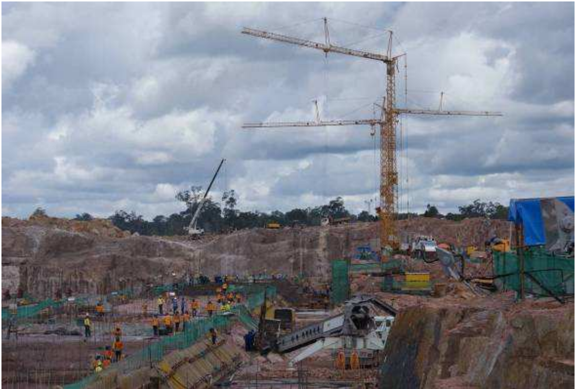
Fig. 1.1: Usina Hidrelétrica do Jirau, 3.300 MW, em construção no rio Madeira (RO), próximo a Porto Velho, a segunda maior usina em construção no mundo hoje
