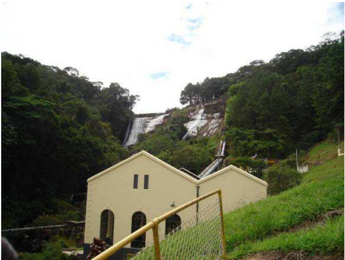
Fig. 2: Usina Hidrelétrica de Salesópolis, 2,5 MW, Rio Tietê, construída em 1913, reabilitada para voltar a gerar por meio do projeto do Museu da Energia, hoje recebe estudantes que em visita ao Museu têm a resposta 'ao vivo' à pergunta: " de onde vem a energia?"
