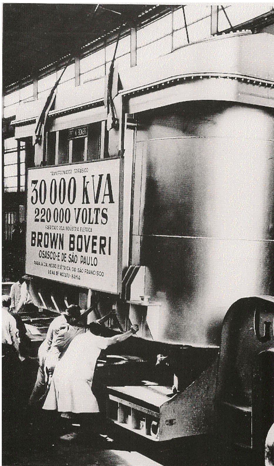
Fig. 2.6: Transformador produzido pela Brown Boveri em Osasco deixa a fábrica para ser entregue à CHERP
