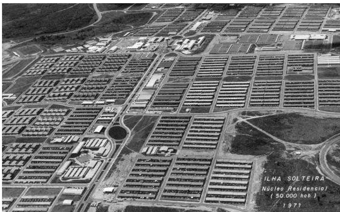
Fig. 1.9: O núcleo residencial de Ilha Solteira, atual sede do município de Ilha Solteira, ao contrário do de Jupiá, não foi desmobilizado e se transformou na sede do município de ilha Solteira, após o término das obras. Na foto podemos observar os diferentes tipos de residência distribuídos em setores de acordo com a função desempenhada pelos trabalhadores da obra
