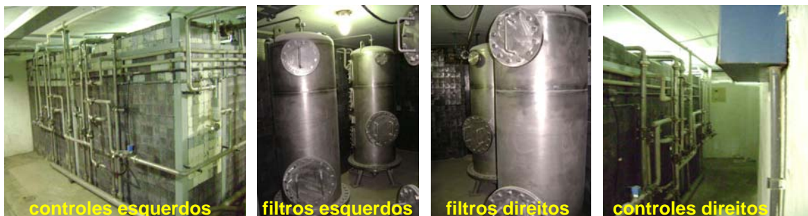
FIGURA 3: Filtros com resina de troca iônica do Reator IEA-R1 do IPEN
