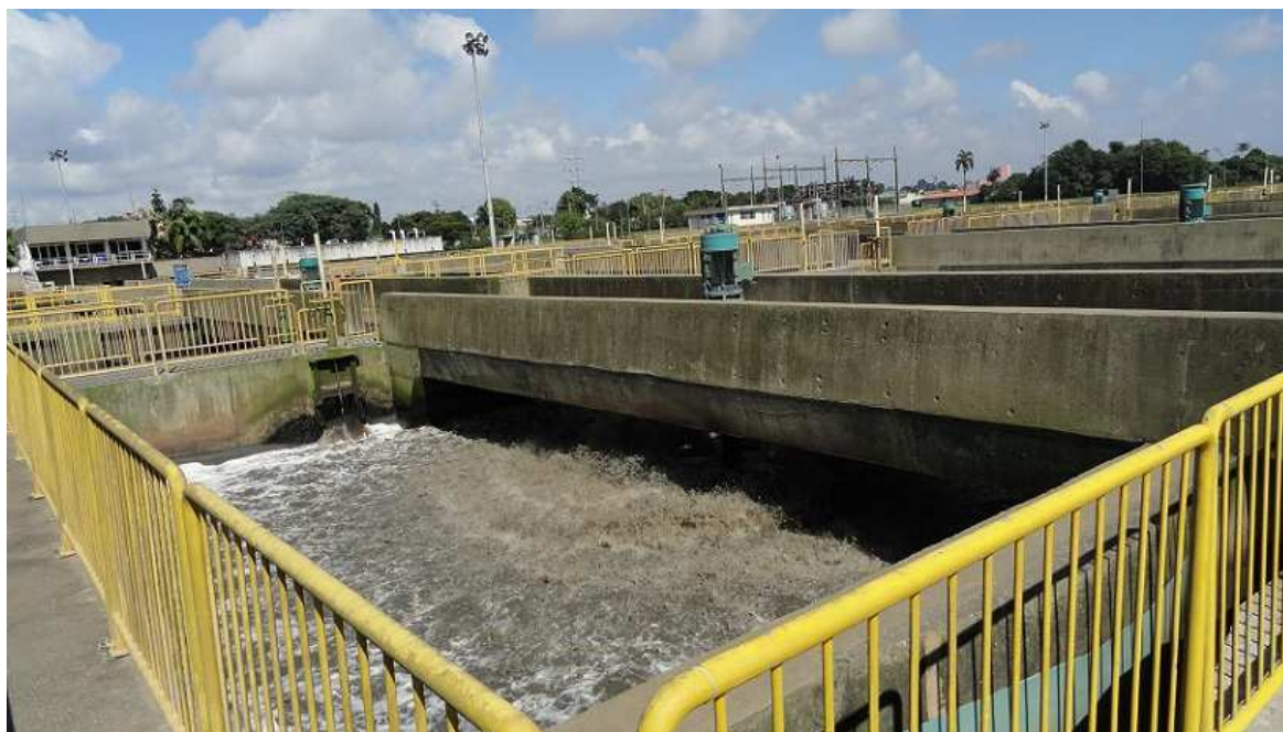
Figura 5.5 - Tanque de Aeração
