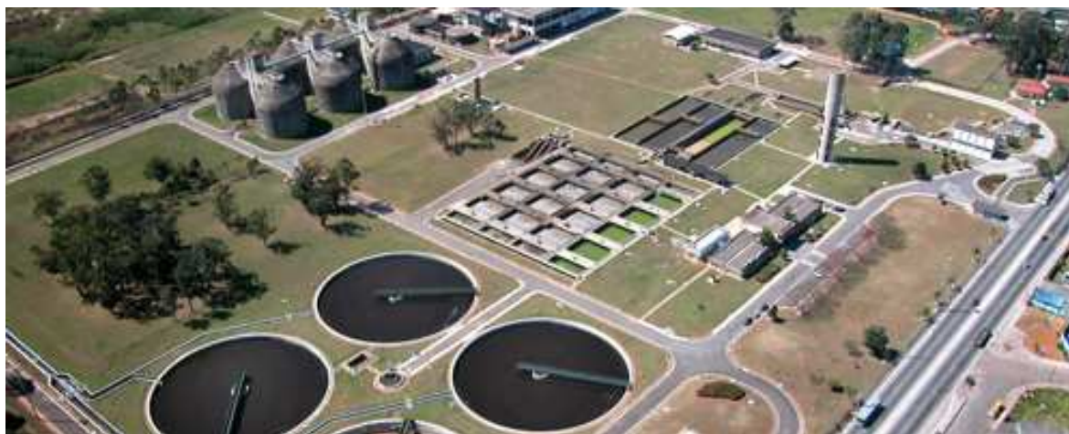
Figura 5.1 - Estação de Tratamento de Suzano – Fonte: SABESP, 2011b
