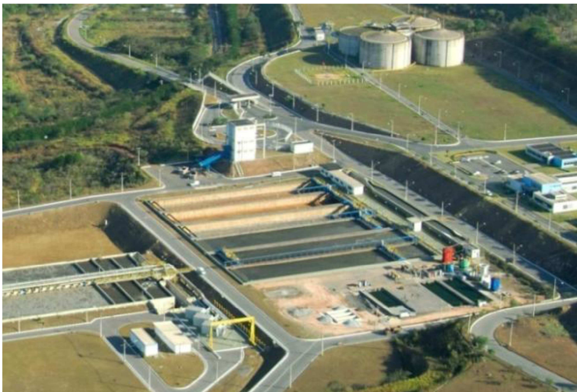
Figura 3.8 - Decantadores Primários da Estação de Tratamento de Esgoto de Arrudas - Fonte: COPASA (2011)
