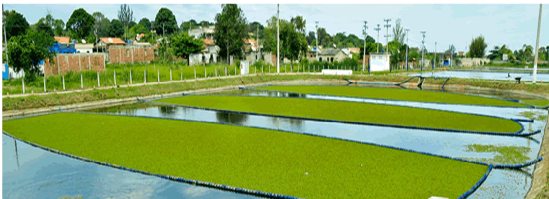
Figura 3.11 - Sistema de Tratamento tipo “ Wetland ” Estação de Tratamento de Esgoto Ponte dos Leites – Araruama RJ – Fonte: Grupo Águas do Brasil (2011)
