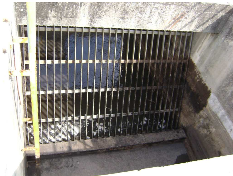
Figura 3.7 - Gradeamento da Estação de Tratamento de Esgoto de Jundiaí - Fonte: CSJ (2011)
