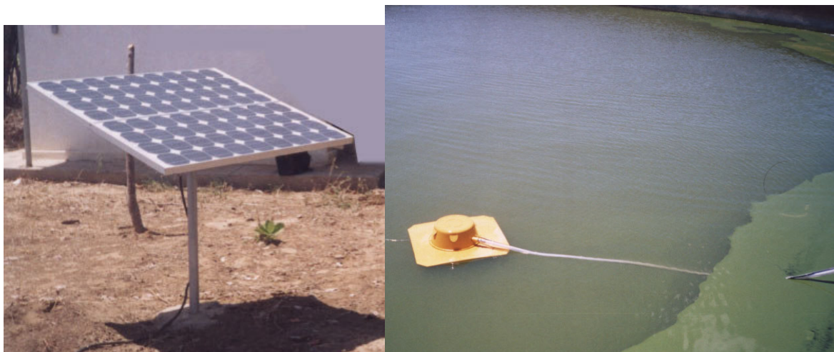
Figura 47 - Sistema fotovoltaico de irrigação instalado na comunidade Cruz da Menina, Patos (PB)
