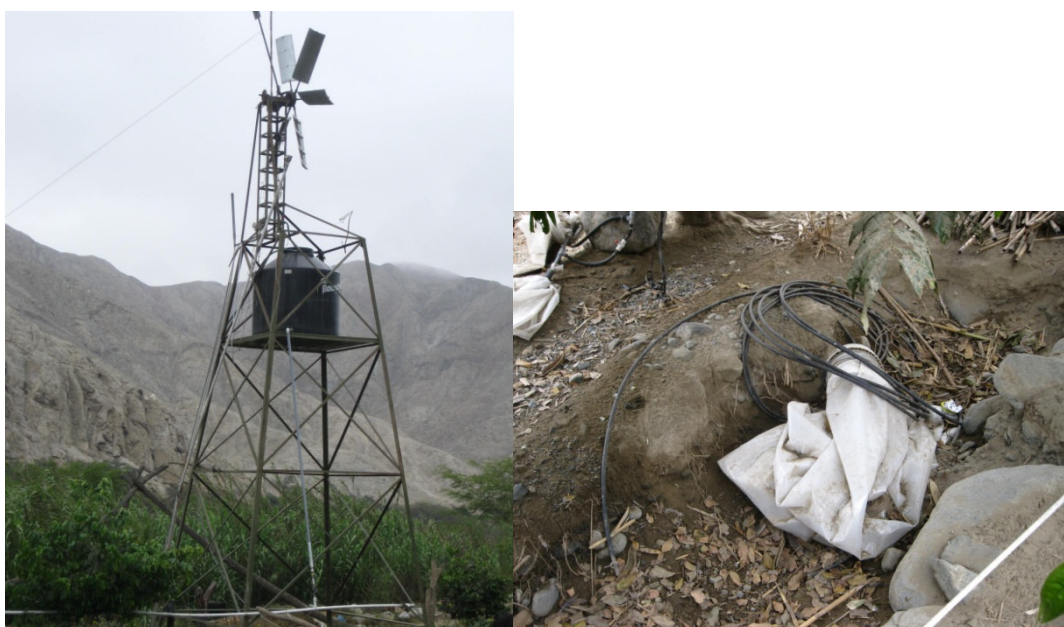
Figura 33 - Cata-vento e biodigestor com excrementos de porquinho-da-índia
