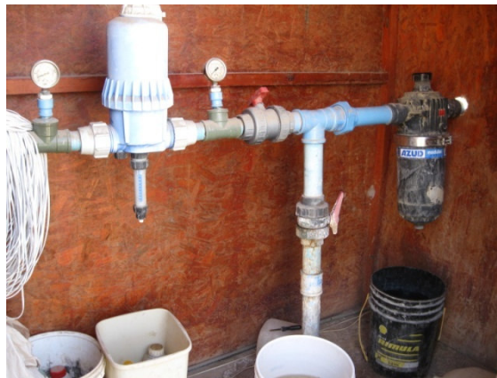
Figura 31 – Cabeçal de irrigação com sistema de filtragem e sistema de fertirrigação
