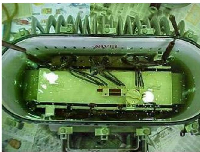
Figura 32- Vista superior da parte ativa, mostrando pouca folga da parte ativa com o tanque
