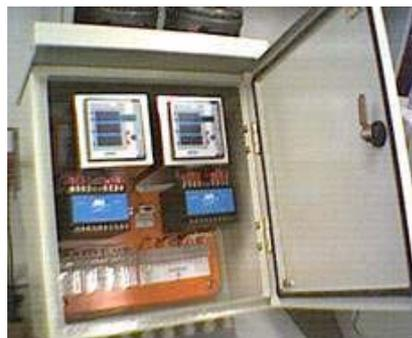
Figura 13 - Foto da caixa com os transdutores e os protetores de sobretensões
