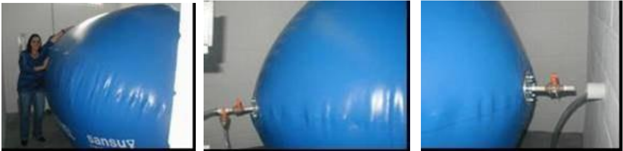
Figura 42. Fotos do gasômetro: armazenador de biogás. Fonte: CENBIO, 2005h.
