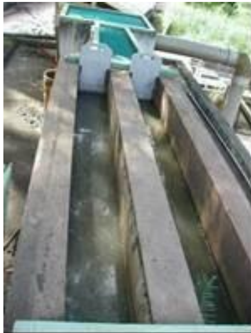
Figura 23. Sistema de pré-tratamento do esgoto. Fonte: CENBIO, 2003c.
