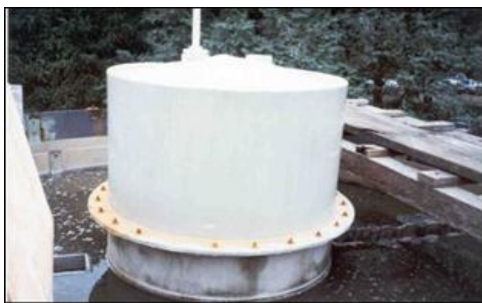
Figura 29. Alongamento da secção de captação do biogás. Fonte: CENBIO, 2004g.
