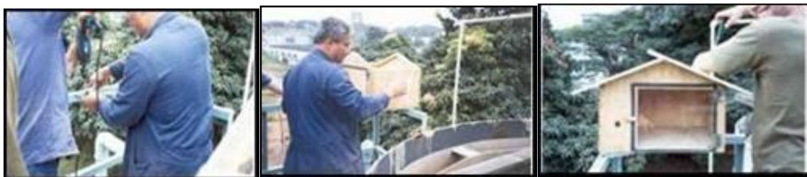
Figura 34. Fotos da instalação do abrigo para o medidor de vazão de biogás. Fonte: CENBIO, 2004 g.
