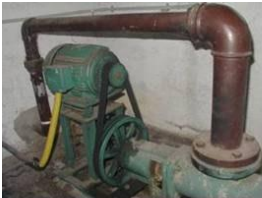
Figura 27. Bomba que leva o efluente para o biodigestor. Fonte: CENBIO, 2003c.
