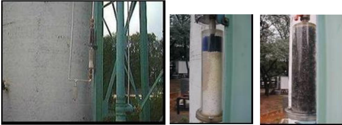
Figura 33. Fotos do sistema de purificação do biogás. Fonte: CENBIO, 2004g.
