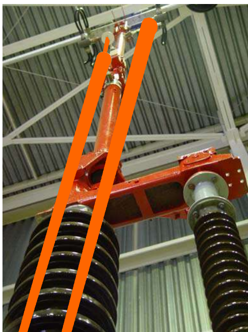
Figura 4.11: Ilustração do feixe óptico do sensor digital de posição aberto/fechado, implementado na chave seccionadora semipantográfica.
