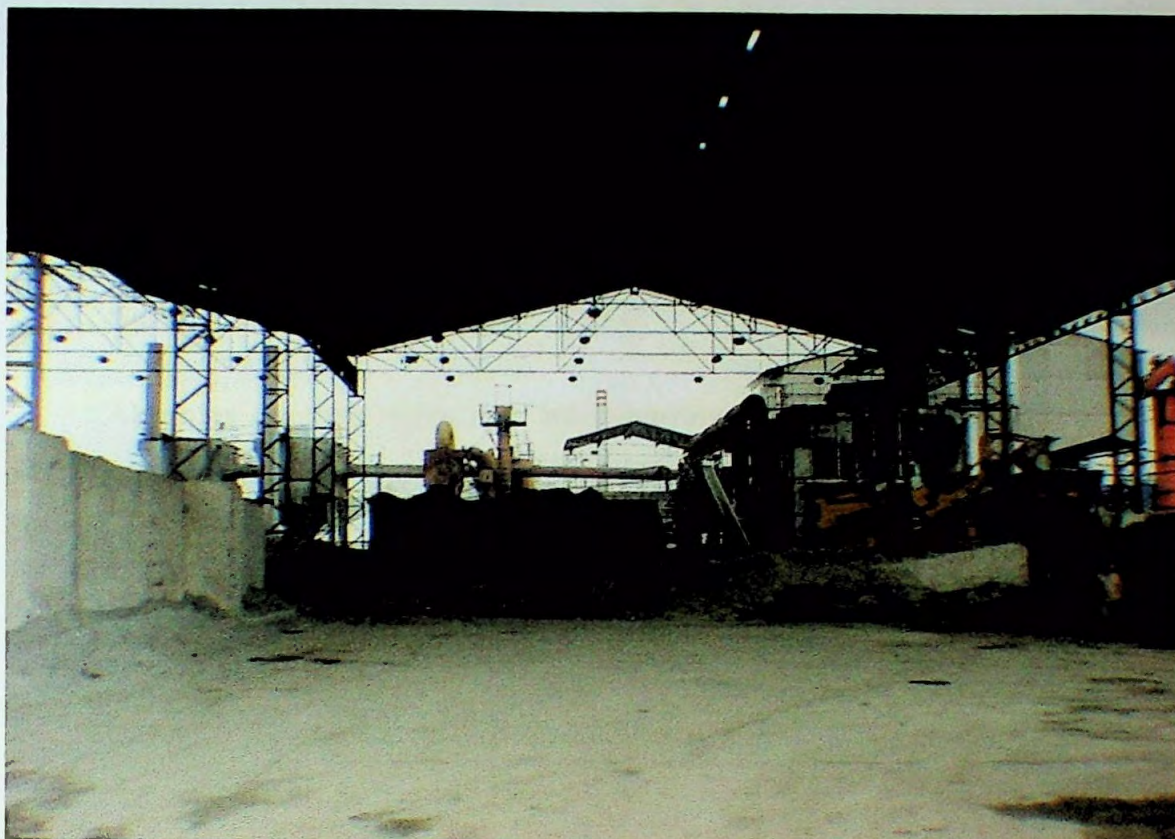
FIGURA 16 - Galpão para depósitos de agregados asfálticos (pedras e pedregulhos), matéria-prima para a produção do asfalto
