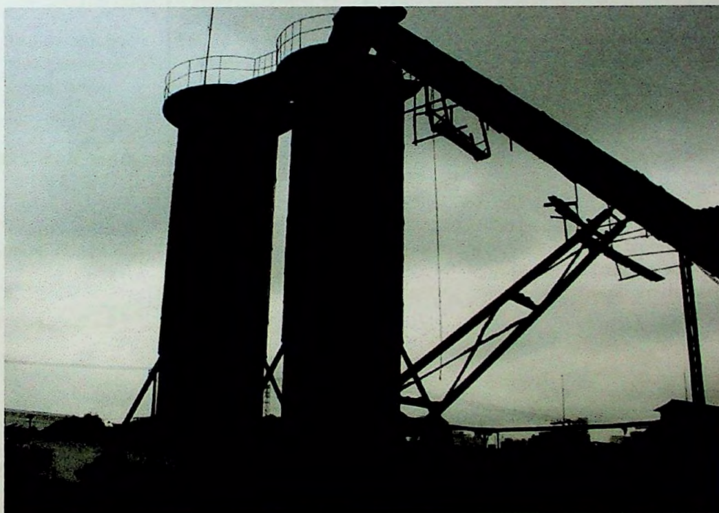
FIGURA 7 – Silo térmico para armazenamento do asfalto produzido e para o abastecimento de caminhões utilizados no transporte do produto para a pavimentação
