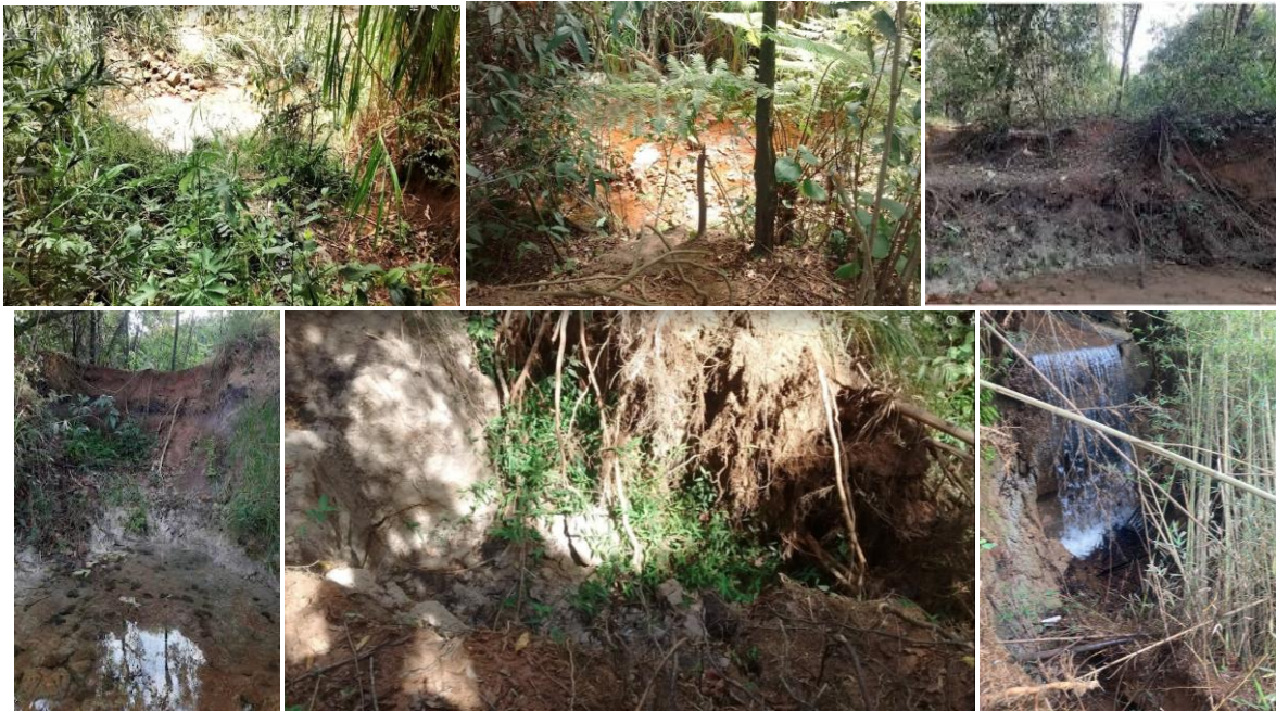
Figura 24 - Nascente do Ribeirão das Cruzes, com detalhe de processos erosivos.
