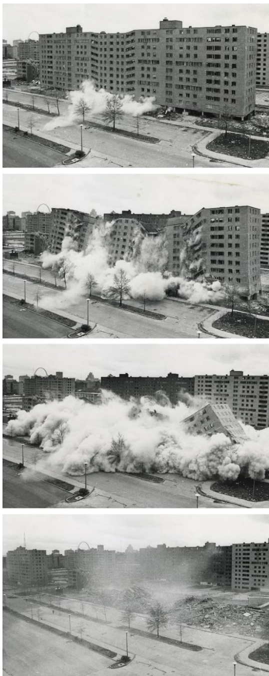
Figura 19 - Stills da demolição do conjunto habitacional Pruitt Igoe, em Saint Louis, EUA, 1972.
