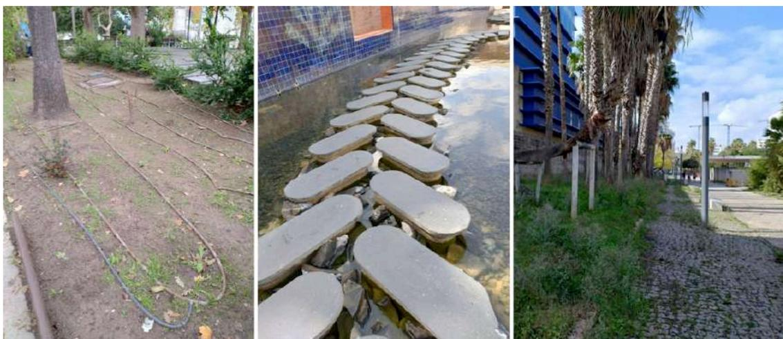
**Fig. 169 - E: Vegetação desaparecida e irrigação exposta; C: pisantes quebrados e soltos, espelho d'água com sujidade; perda de limites entre pavimentos e vegetação. 2023, Acervo do Autor.**
