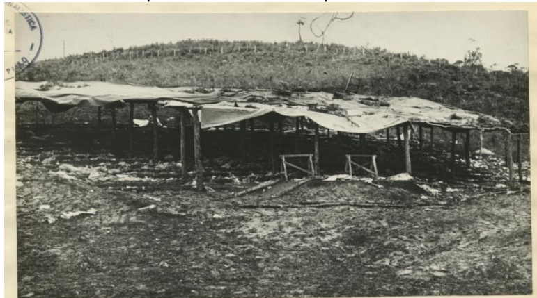
Figura 51 A – Barraca improvisada construída para ser o anfiteatro do congresso
