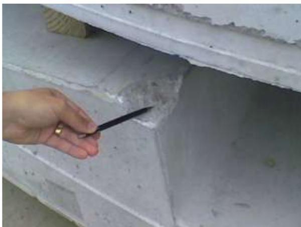
Figura 5.3 – Exemplo de dano superficial de segmento produzido com reforço convencional (Figueiredo, 2009).
