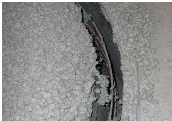
Figura 6.9 – Armadura posicionada na fôrma que reduz a velocidade de entrada do material(Figueiredo, 2010k).
