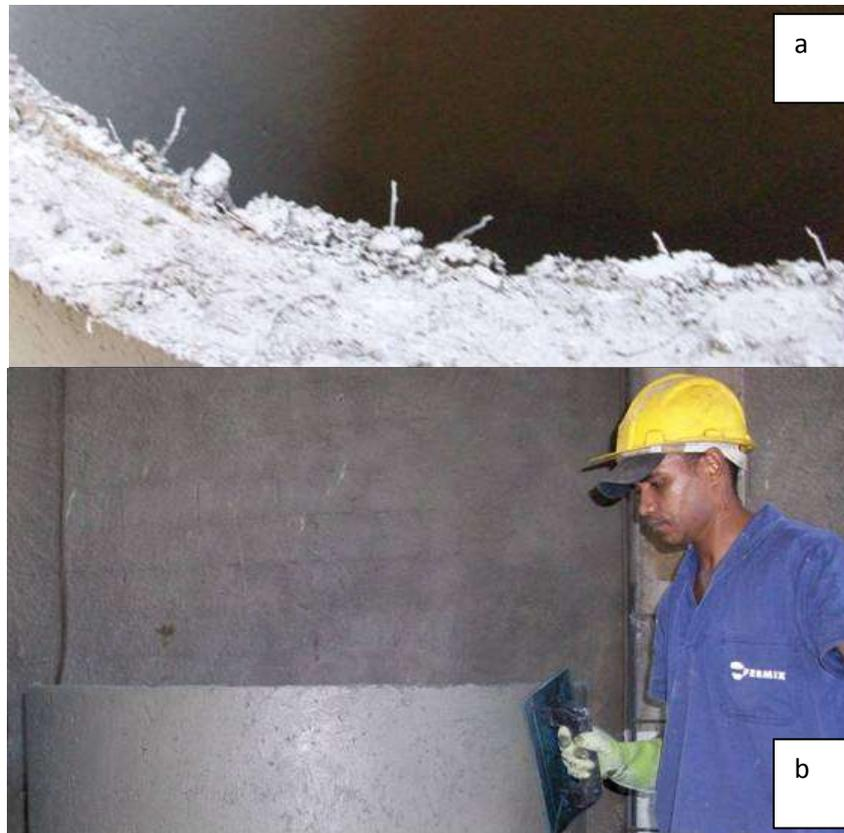
Figura 6.10 – Fibras expostas na região da ponta do tubo (a) (Figueiredo, 2010l) e serviço de acabamento da região com remoção das fibras (b) (Figueiredo, 2010m).
