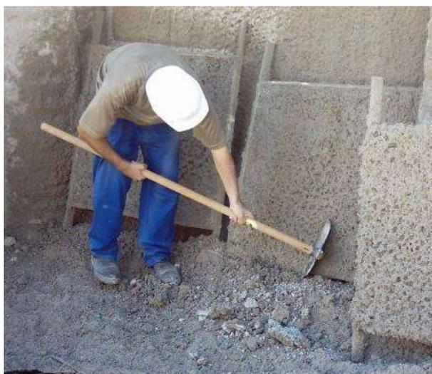
Figura 4.18 – Nivelamento superficial da placa recém projetada (Figueiredo, 2005c).
