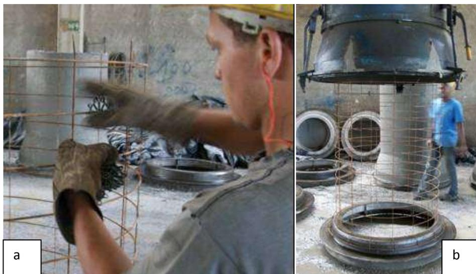
Figura 6.4 – Fixação de espaçadores (a) (Figueiredo, 2010c) e colocação da armadura na fôrma apoiada no anel metálico de fundo (b) (Figueiredo, 2010d).
