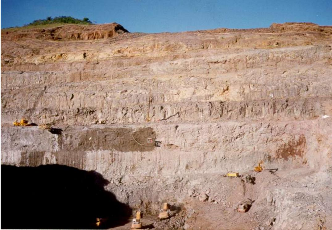
Figura 5.16 – Escavação da realizada durante a construção da barragem de Itá (SC) com a projeção de CRF para proteção contra o fenômeno do *rock bursting* (Figueiredo, 1998).
