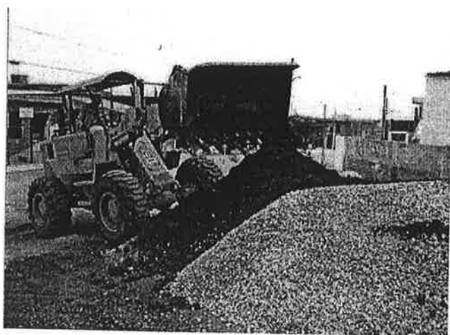
(a) processo construtivo de mistura de solo argiloso laterítico com brita.
