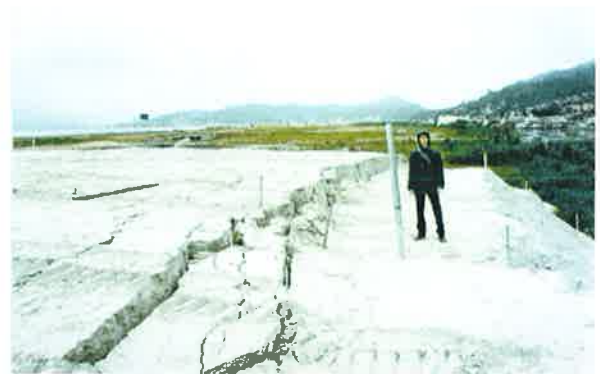
(b) Aterro AE 3 - sem drenos e sem reforço
